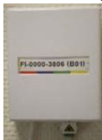
Figure 6 : FTTE passif PM - exemple de PTO
